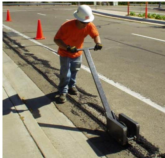
Figuur 22. Micro trenching
