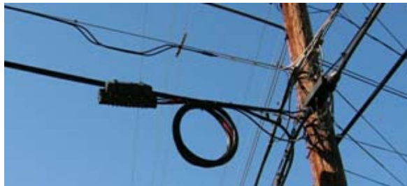
Figure 22 Fibre optique déployée par des poteaux. (Source: UGent)
